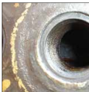
Agujero de tapón precio re mecanizado de asiento.
