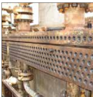
Enfriador FinFan antes de mantenimiento.
